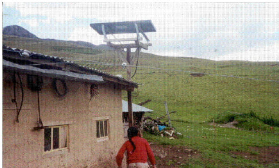
Gráfico N° 1: Componentes del SFD de 53 Watts.
